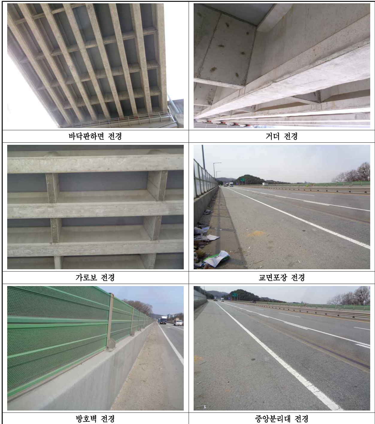
【사진 1.2.2】 상부구조 현황
