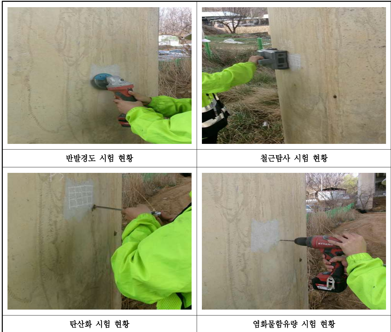
【사진 1.3.1】 콘크리트 내구성조사 현황
